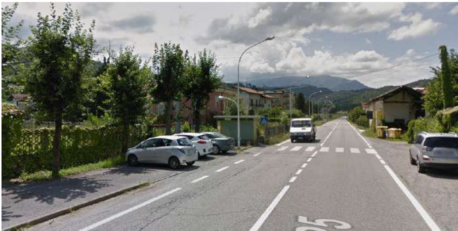
Tratto viabilità ciclopedonale Viale Cerri
