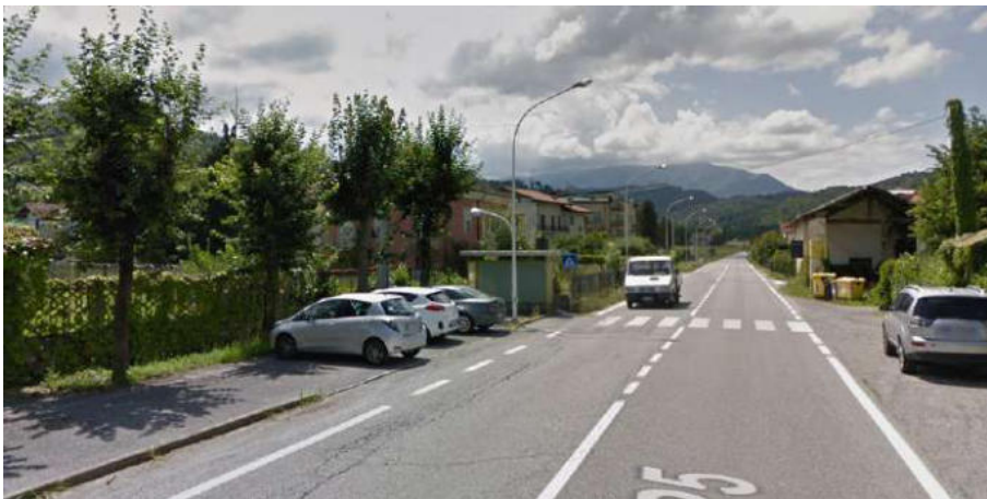
Tratto viabilità ciclopedonale Viale Cerri
